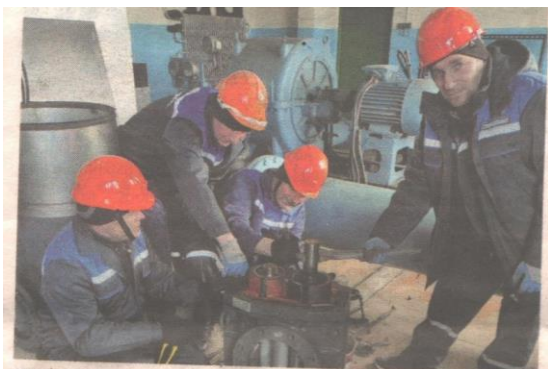
Машинисты насосных и компрессорных установок очистных сооружений ведут наладку оборудования
